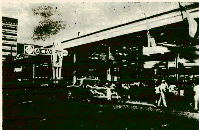
Instalaciones del nuevo centro servicial que el AGA habilitó en Trelew.
