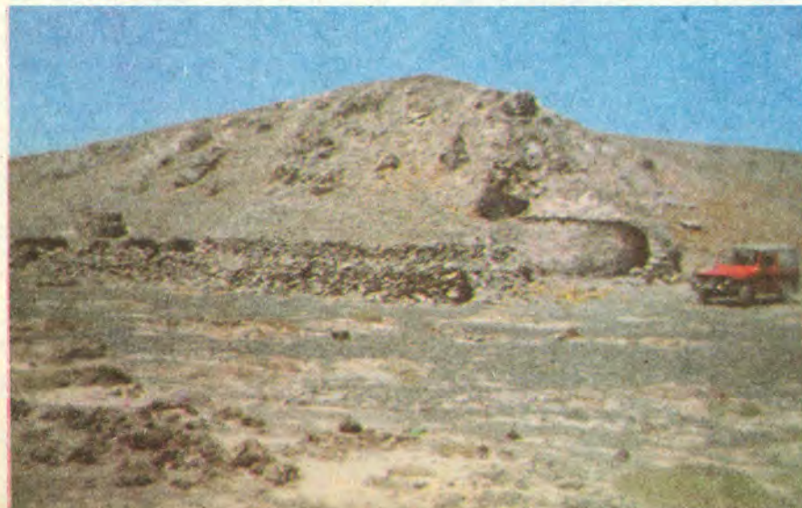
Refugio andino de Pastos Amarillos, situado a 80 km de Jagüé, último centro poblado antes de iniciar la difícilísima travesía por el paso de Comecaballos.
